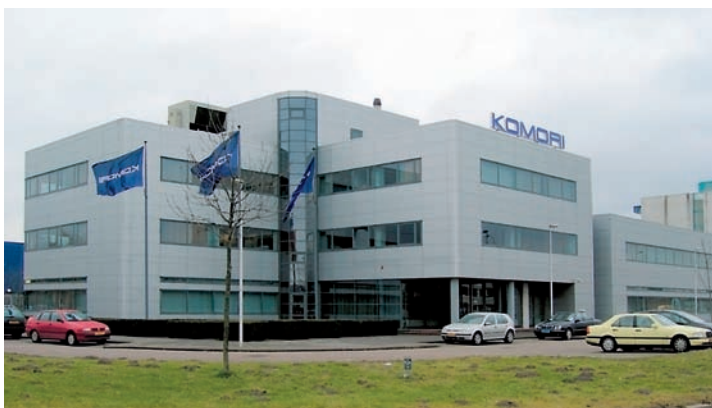
Slika 12. Komorijeva evropska centrala v Utrechtu na Nizozemskem.
